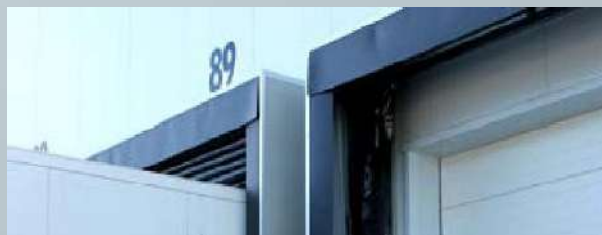
Cais carga / abrigos
