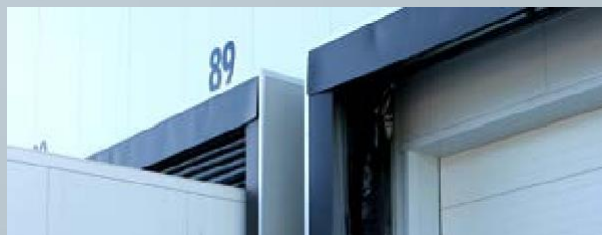
Cais carga / abrigos
